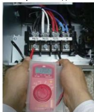
* Измерение входного напряжения
