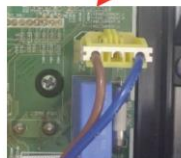
Линия постоянного тока подключена
