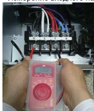
* Измерение входного напряжения
