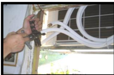
( Работы по трубопроводам и проверка вальцовки )
