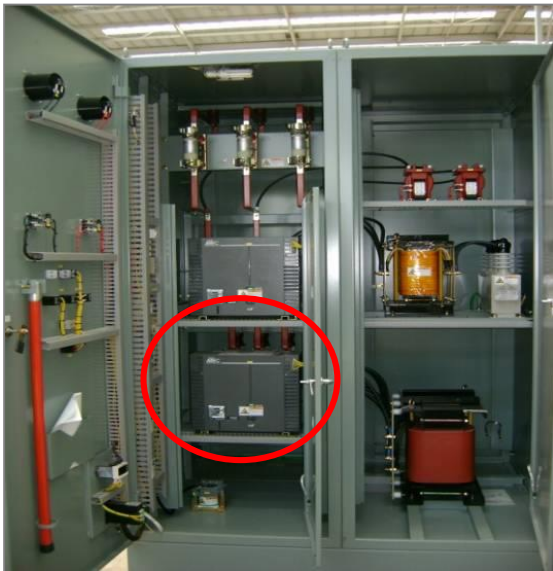
2M магнитное реле панель запуска
