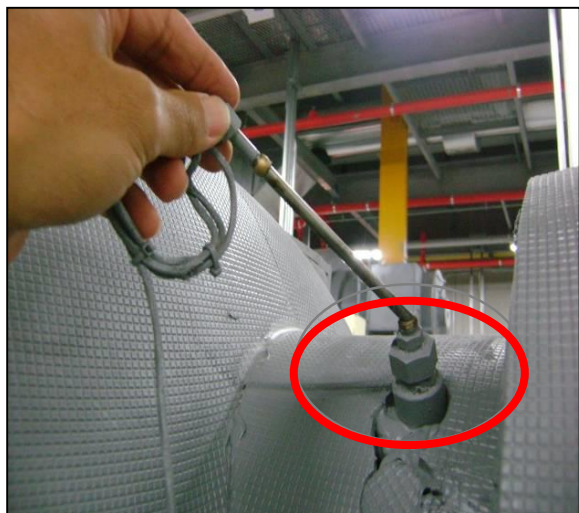
Датчик температуры охлажденной воды на выходе
