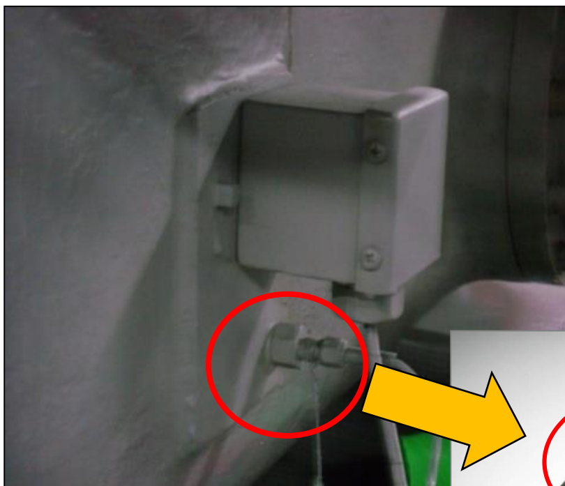
Датчик температуры подшипника
